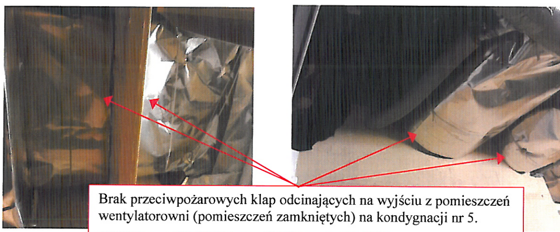
Fot. 12. Widok nieprawidłowości w zakresie braku stosowania przeciwpożarowych klap odcinających na kanałach wentylacyjnych na wyjściu z wentylatorowni. Nieprawidłowości do usunięcia – przewiduje się zastosowanie ppoż. klap odcinających sterowanych przez system sygnalizacji pożarowej.
