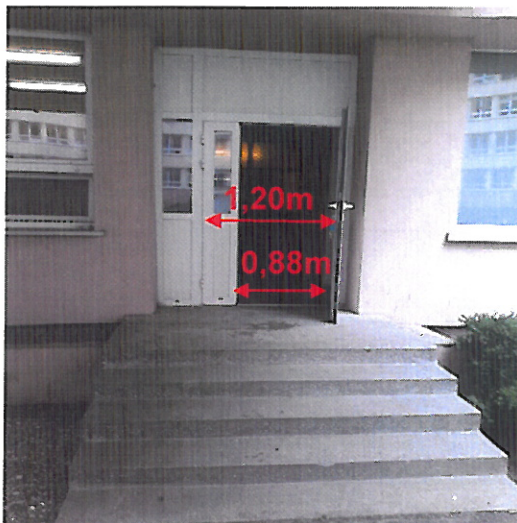
Fot. 3. Widok wyjścia z komunikacji przy klatce schodowej KG B-C (kondygnacja nr 1 prowadzące na zewnątrz budynku – dziedziniec wewnętrzny). Istniejące drzwi o łącznej szerokości 1,2m (88+32cm) przewidziane do wymiany na drzwi o szerokości w świetle ościeżnicy 1,4 m (100+40cm).
