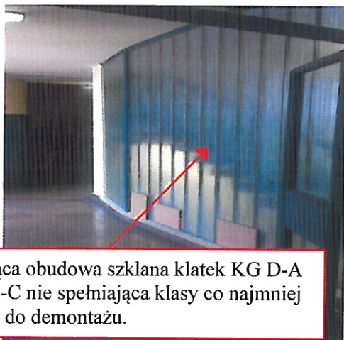
Istniejąca bezklasowa obudowa pomieszczeń zlokalizowanych w obrysie klatek schodowych do wymiany na obudowę w klasie REI 60 z drzwiami EIS 30.
