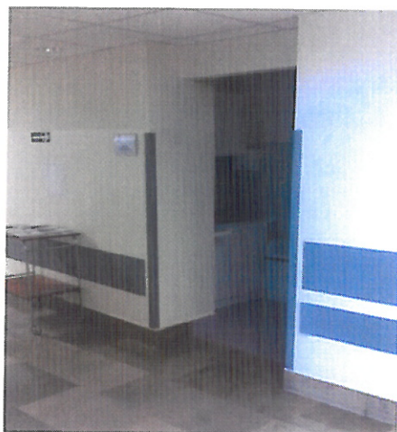
Fot. 5. Brak zamknięcia drzwiami kuchni oddziałowej od komunikacji. Nieprawidłowość do usunięcia.
