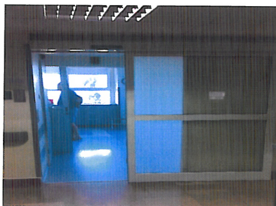
Fot. 1. Widok drzwi przesuwnych z sali chorych na komunikację na oddziale kardiologii. Wszystkie drzwi przesuwne stosowane na drogach ewakuacyjnych będą sterowane przez system sygnalizacji pożarowej.
