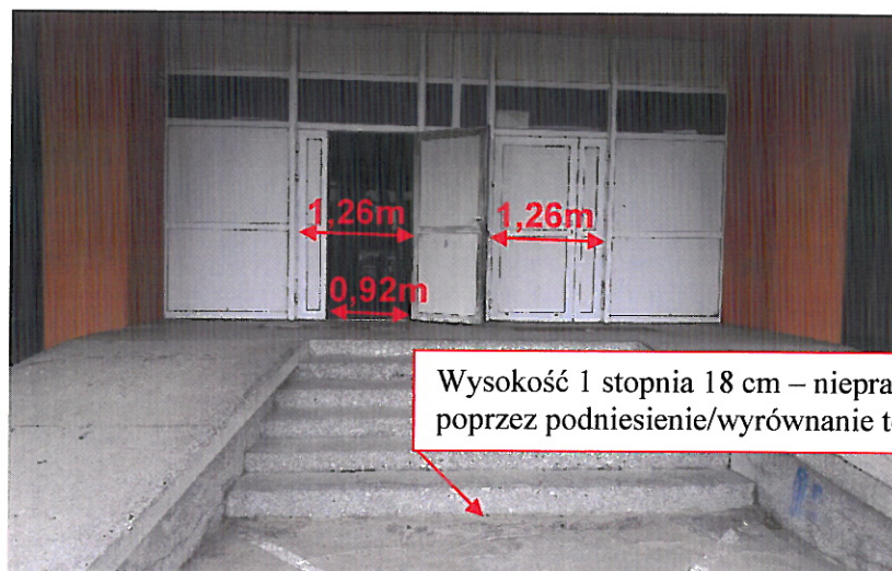
Fot. 2. Widok wyjścia z komunikacji przy klatce schodowej KP A-B (kondygnacja nr 1) – elewacja frontowa od strony północo-zachodniej. Zastosowano 2 szt. drzwi o
